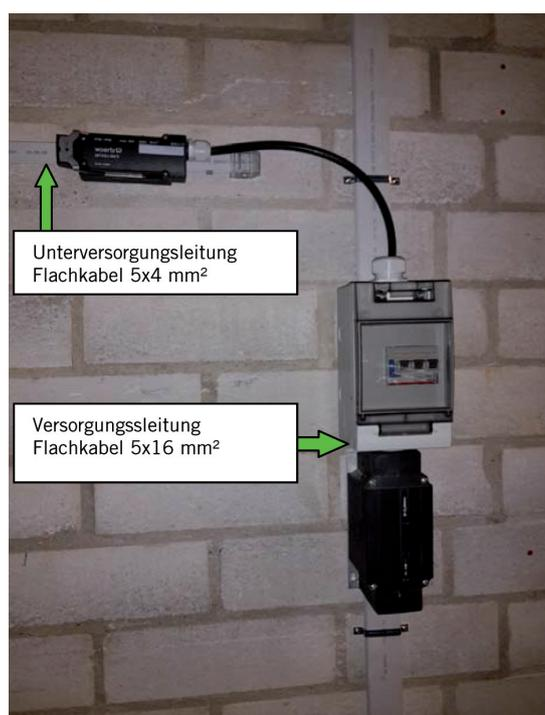
Versorgungsleitung 5x16 mm<sup>2</sup> horizontal verlegt mit Reihenabzweigungen auf 32 A Steckdosen.
