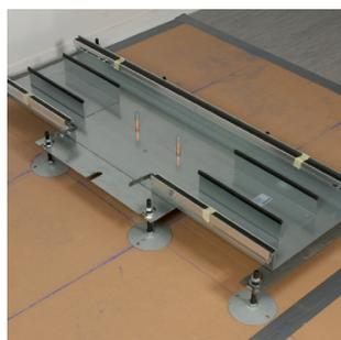
7. Für allfällige Winkel-, Kreuz- und T-Verbindungen Nivellierplatte mit 4 Nivellierfüssen auf Rohboden stellen und die entsprechenden Verbindungsstücke auslegen.
