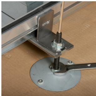
10. Kanalschale ab Meterriss auf Abzugskantenhöhe (1 m + Schutzkantenhöhe) horizontal bei den Nivellierfüssen einnivellieren und festziehen. Anzustreben ist eine Toleranz mit Nivelliergerät (Laser) von +/- 1 mm.
