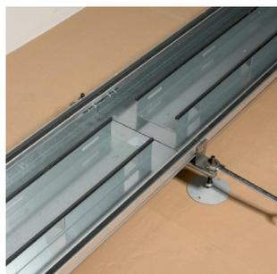
8. Befestigungswinkel bei den Nivellierfüssen, Profilaussenseitig einhaken. Kanalhöhe vornivellieren (Toleranz +/- 3 mm)
