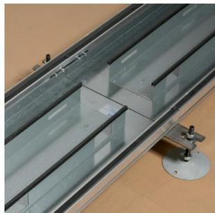
6. Kanalschalen mit eingeschobenen Verbindungslaschen (Nut auf Innenseite des Kanals) auf Nivelliervorrichtungen auslegen und aneinanderreihen. Für Längenanpassungen, Kanalschalen am einfachsten mit einer Einhandtrennscheibe zuschneiden.
