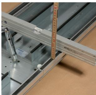
8. Kanalschale ab Meterriss auf Abzugskantenhöhe (1 m + Schutzkantenhöhe) horizontal mit den Nivellierschrauben einnivellieren. Anzustreben ist eine Toleranz mit Nivelliergerät (Laser) von +/- 1 mm.
