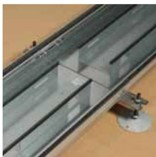
7. Kanalschalen spannungsfrei mit Nieten  $\varnothing$  4.8 mm bei den Verbindungsplatten vernieten.
