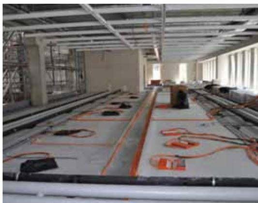
Diejenigen Platten, die an die vorgesehenen Anschlussstellen zu liegen kommen, haben seitlich Kabelausslässe oder werden zum Einbauen von eckigen oder runden Rahmen mit Deckel ausgeschnitten.
