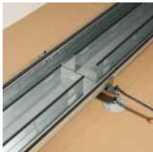
9. Kanalschalen innen mit Rohboden verschrauben. Nachkontrolle der horizontalen Höhe mit Nivelliergerät. Wenn die Nivellierschrauben aus Kunststoff über die Kanalkante hinausstehen, so können diese mit einem gezielten Hammerschlag entfernt werden.
