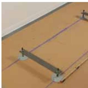
6. Kanalhöhe vornivellieren (Toleranz +/- 3 mm). Kanalschalen mit Verbindungslaschen miteinander verbinden und Laschen festziehen. (Schlüsselweite 10 mm)
