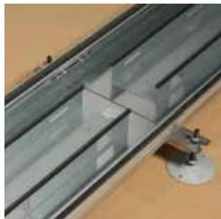
6. Kanalschalen mit eingeschobenen Verbindungsblaschen (Nut auf Innenseite des Kanals) auf Nivelliervorrichtungen auslegen und aneinanderreihen. Für Längenanpassungen, Kanalschalen am einfachsten mit einer Einhandtrennscheibe zuschneiden.
