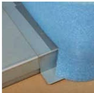
13. Bauseitig müssen die Zugdosens und Anschlusskasten vor dem Einbau des Unterlagbodens mit einem Stellstreifen versehen werden.
