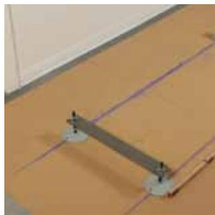
5. Nivellierfüsse und Nivellierstege 90 Grad zur Kanalschale jeweils hälftig links und rechts der Schalenstossstelle sowie mittig verteilen. Pro Meter Kanalschale muss eine Nivelliervorrichtung (Füsse/Steg) verwendet werden.
