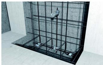
Erfahren Sie, welche besonderen Massnahmen bei der Verwendung eines im Betonfundament verlegten Leiters, auch als Banderder bekannt, zu beachten sind.
