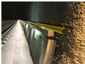
Système de main courante E90 avec éclairage LED intégré et distribution de courant par câble plat avec éclairage LED intégré et distribution de courant par câble plat pour l'orientation des chemins de fuite pour les tunnels routiers et ferroviaires avec maintien de la fonction E90. Difficilement inflammable, sans halogène et autoextinguible. Système E90 selon la norme DIN4102-12.
